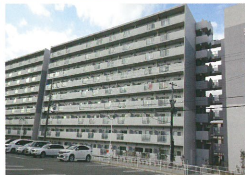
建て替え後の県営野間団地
