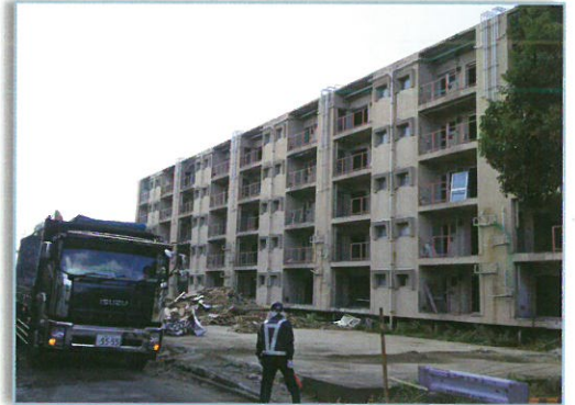
解体中の県営中野鉄筋住宅。市に敷地約1万㎡が返却され、来年度に売却予定。10億円は下らないでしょう。
