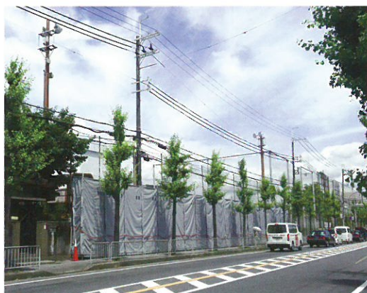
市高のプールを取り囲んでいたブロック塀は、すぐに撤去されました。
